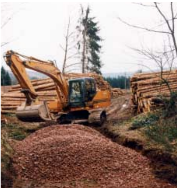
Le bois est sorti en forêt de Brouvelieures (88) et l'accès est consolidé
