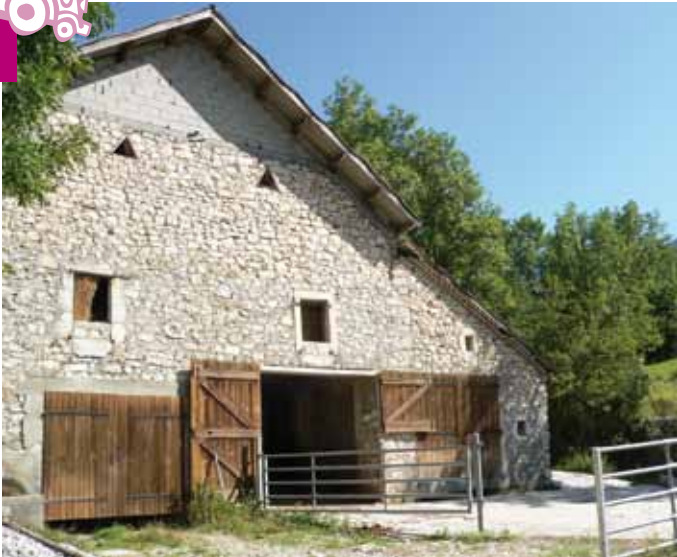
Grange aménagée pour les chauves-souris lors de sa rénovation.
