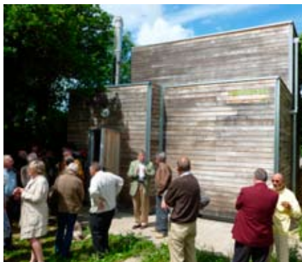
Vue d'ensemble de la chaufferie de la Maison de Courcelles.
